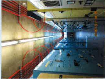
Illustration de réseaux de détection incendie par prélèvement d'air en Armoires électriques
