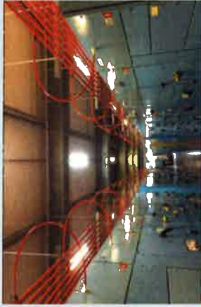
Illustration de réseaux de détection incendie par prélèvement d'air en Armoires électriques
